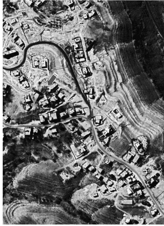
اليوم يوجد برج خزان مياه، قرية ات تقربوست - يفرن المدينة 2023
